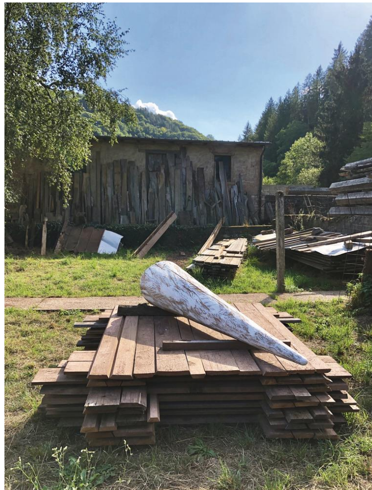
Flutsockel mit Lot und Schlammspuren der Überschwemmung
