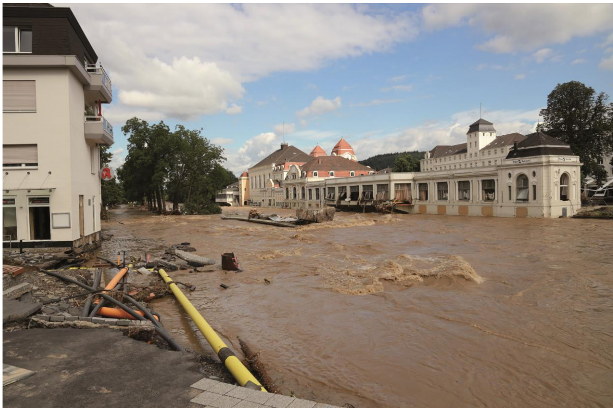
Aufnahme der Kurgartenbrücke Bad Neuenahr am 15.07.2021
